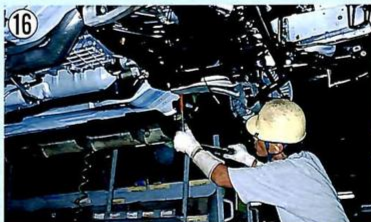
◀もちろん通常のトルクレンチも使って、各部のボルト・ナットを締め付ける。その後、締め忘れがないか、再度チェックする行程がある。
