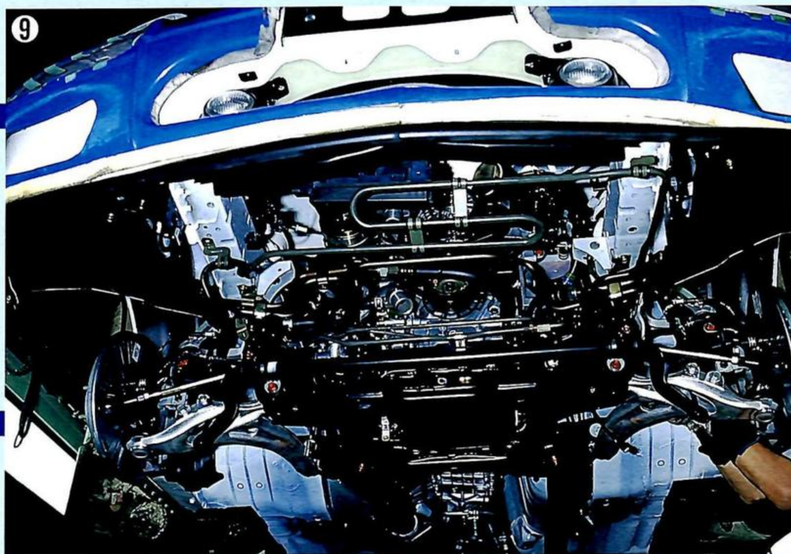
▲工具を持って作業する動きは、ボディにどこかをぶつけることもなく、必要なボルトの仮締めは素早い。エンジン、ミッションが組み付けられると、なんとなくクルマらしくなる。
