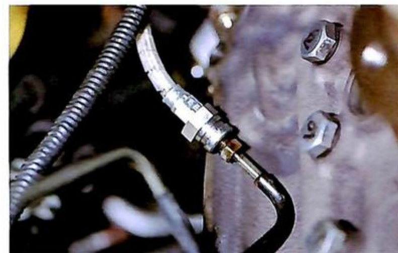
19 本来はこうにクラッチマスターシリンダーからのホースとリリースシリンダーのパイプが接続されているが、そのリリースシリンダーは不要となる。
