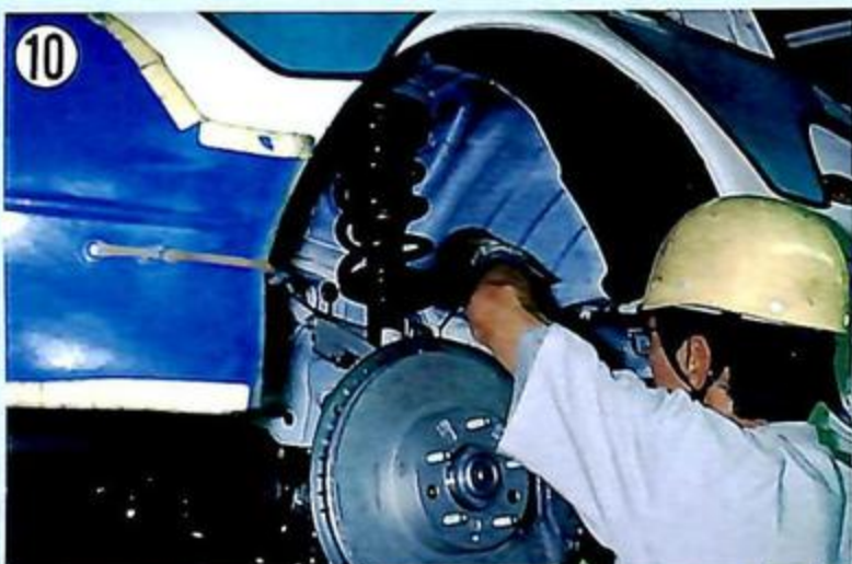
▲メンバーから手を離れたかと思ったら、次の瞬間アッパーアーム取り付けボルトの締め付け。
