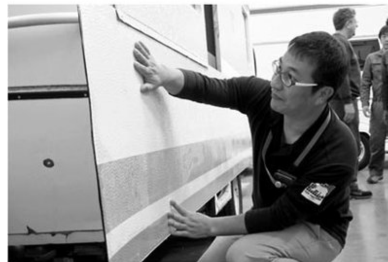
●その後、モールとマーカーランプ、外部につながるボイラー、電源などの戻しの作業を行ない、片面のアルミボディパネルの修復は終了した
