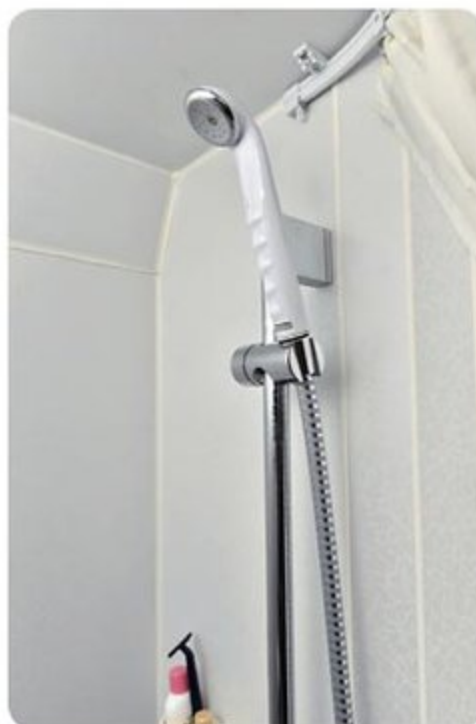
●シャワールームは何と自作。内壁の継ぎ目のコーキングやシャワーのステーなど、自分仕様となっており使い勝手を向上させている
