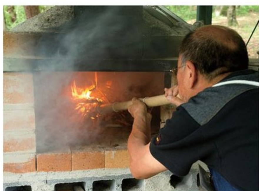
●耐火レンガを200個以上積み上げたピザ窯は昨年新調したばかり。着火から窯全体に火がまわるまで1時間以上かかる
