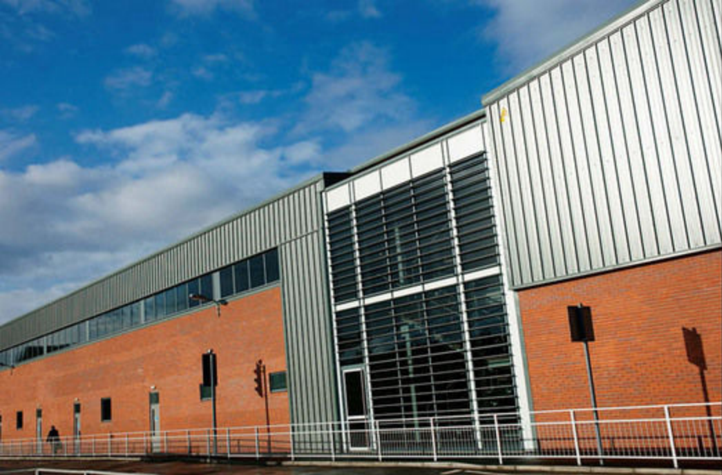
ミュルザンヌから採用されたスーパーフォーミング製法のボディパネルをはじめとする新しい製造ラインを構築するために、敷地内に2008年に建設されたボディ工場。実に7500㎡という広さを誇る。
