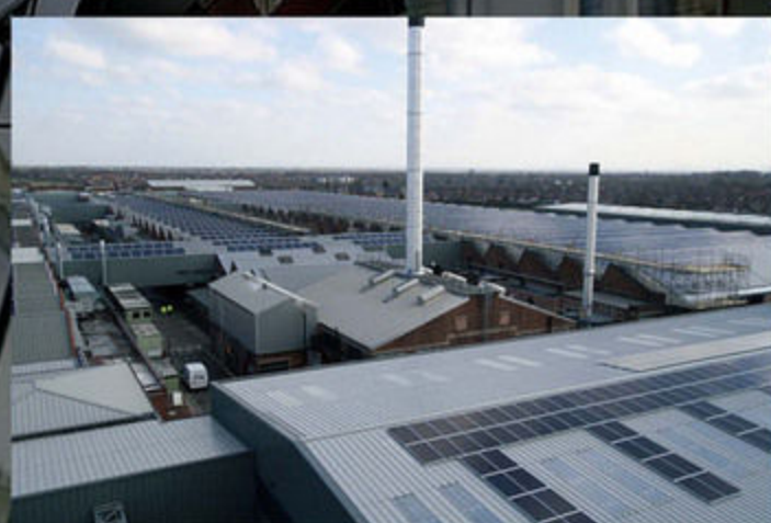
1938年に設立された当時の景観と近代的なエントランスが見事に調和するベントレー・クルー本社工場。昨年春には工場屋根に2万枚ものソーラーパネルが設置され最大で40%の電力を賄うことが可能になったほか、年間2500トン以上のCO 2 削減に寄与している。
