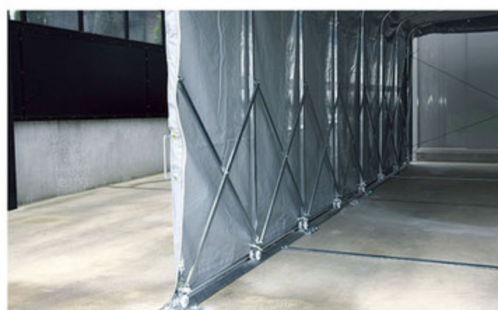
ガレージの内側を見ると、8本前後のスチール製の柱にX印の筋交いが入るフレームを使用していることが判る。子供のボール遊びのボールが飛んできてもビクともしない。
