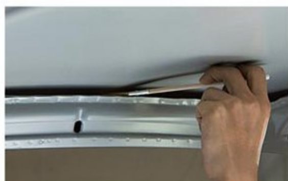
天井淵の入り組んだところには、このように防錆サフェーサーを筆塗りしている。スライディングルーフがなくとも作業は念入りに。
