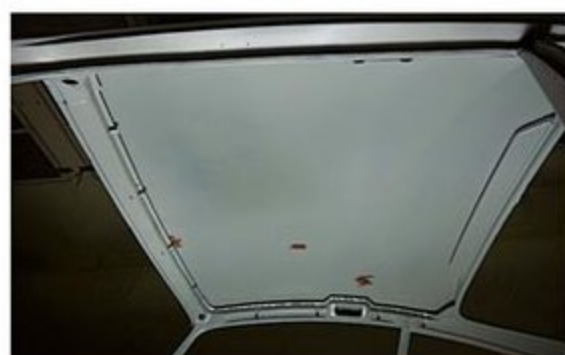
トリムの糊などが残っていた天井も綺麗に研磨され、防錆サフェーサーが塗布されていった。赤い部分はアルミ粉入りパテの修正跡。
