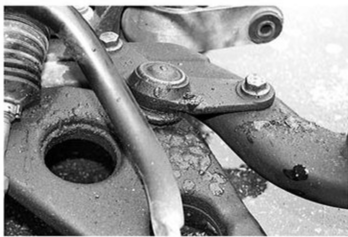
コントロールアームのジョイント部からグリースがにじんでいる。ここは交換しておきたいところだ。
