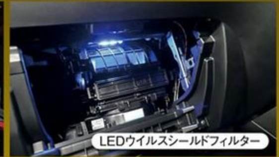
サニティシステム施工
