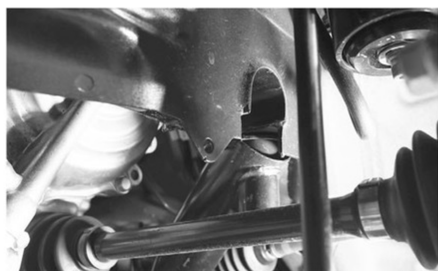
フレームに切り込みを入れるのがトンネル加工。アームロックはロアアームの加工が必要となる。エグゼスタイル310では、もちろん諸々のワンオフにも対応。
