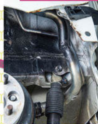
燃料パイプ移設加工
