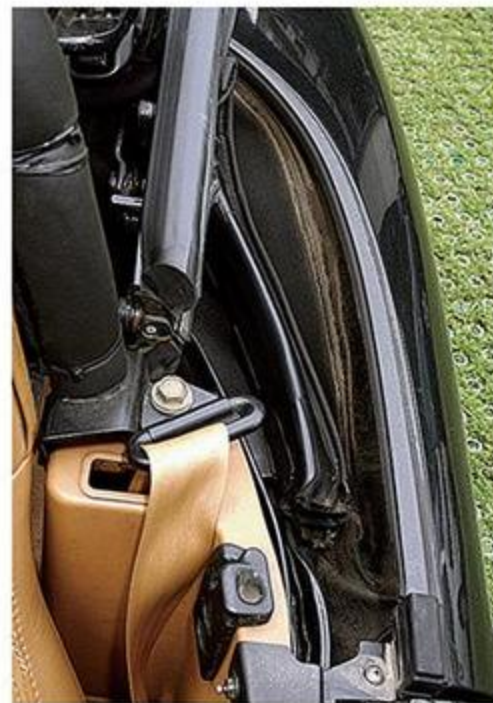
シートベルトの取り付け付近にある水抜き穴、ときどき長い棒状のものでつついて、ゴミがないかチェックしよう。ここを見れば、普段のメンテナンスが行われているか、一発分わかってくる。
