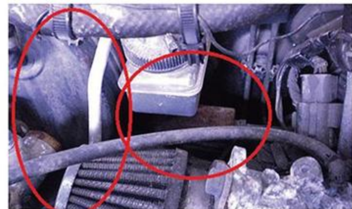
エンジンルーム内にはアルミの腐食やサビが至るところで発生していた。カバーをかけていたから、余計に悪化してしまった?
