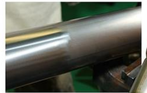
チタンパイプは、溶接前に下地処理を施し、点付け溶接後、本溶接となる。特殊な設備と技術がないと、チタンのワンオフは難しい。
