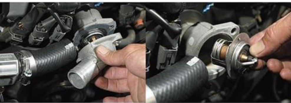
熱対策を実施する際には、サーモスタットのほかにもホース類が劣化していたら、中途半端にせず新品に交換しておきたい。
